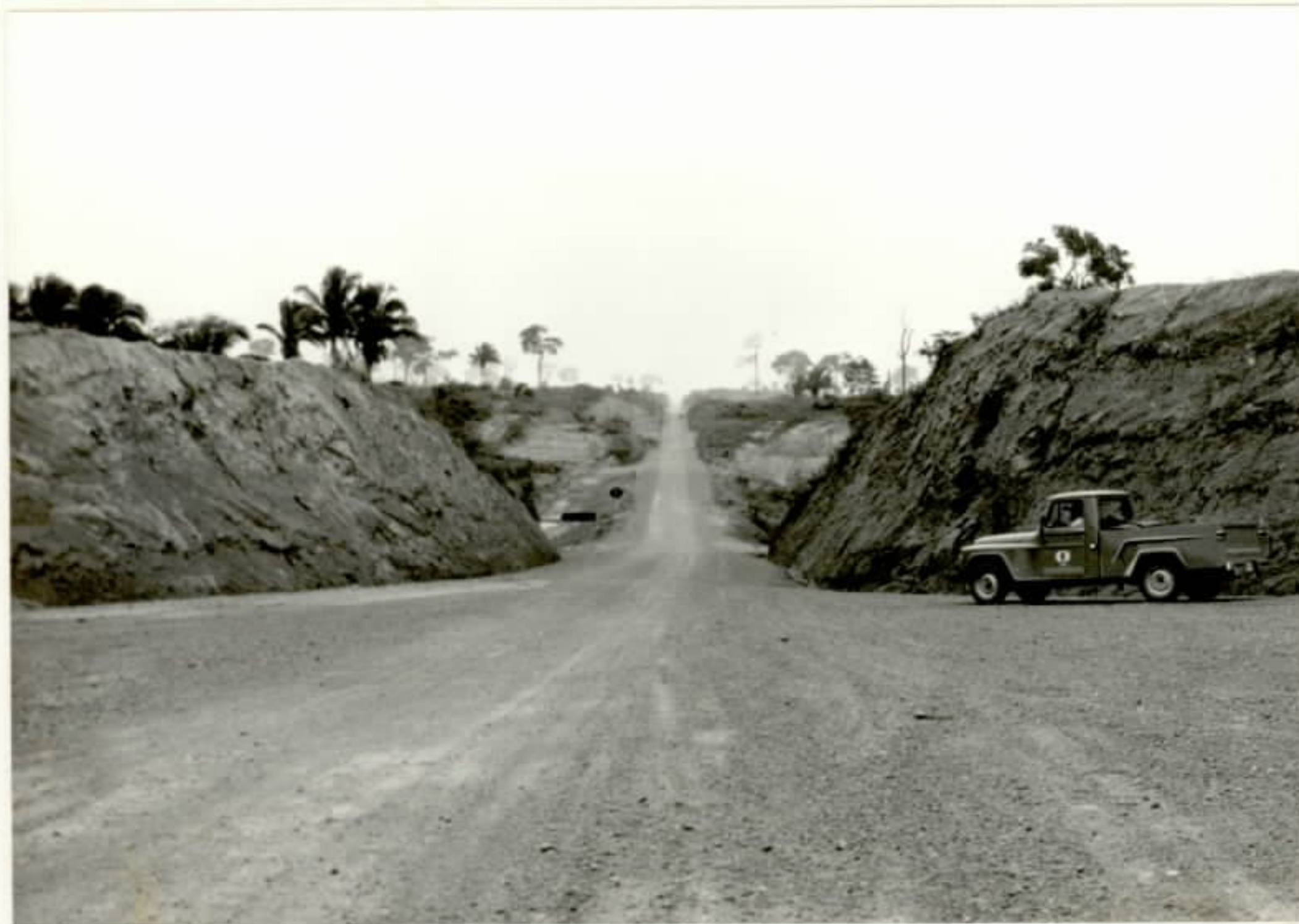
Foto 05a - Cruzamento da Transamazônica com a rodovia PA-70. O traçado da estrada atravessa rochas de baixo grau de metamorfismo, do Grupo Tocantins.
