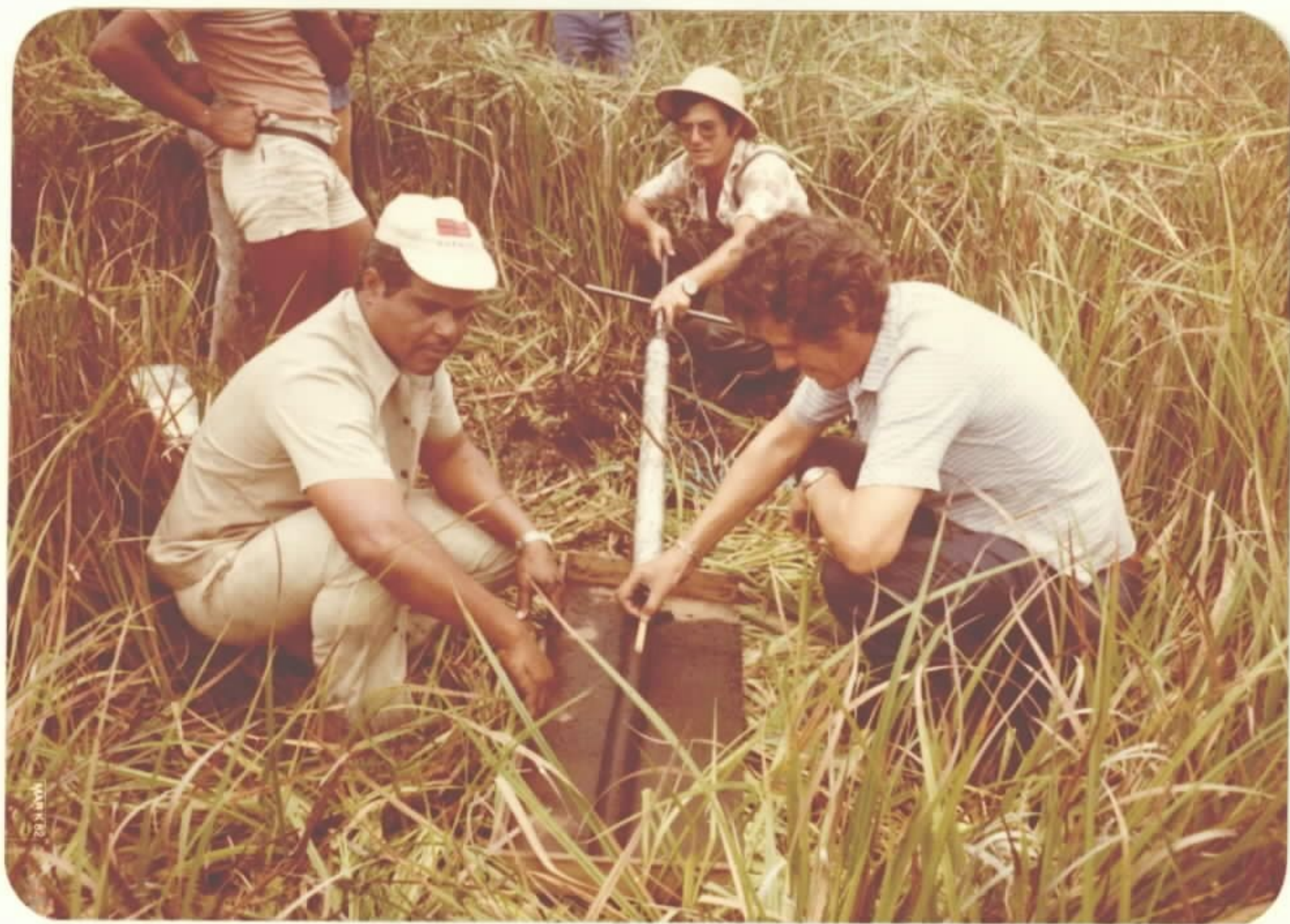
FOTO 2 - Retirada de testemunho (amostra indeformada) com amostrador de pistão.
