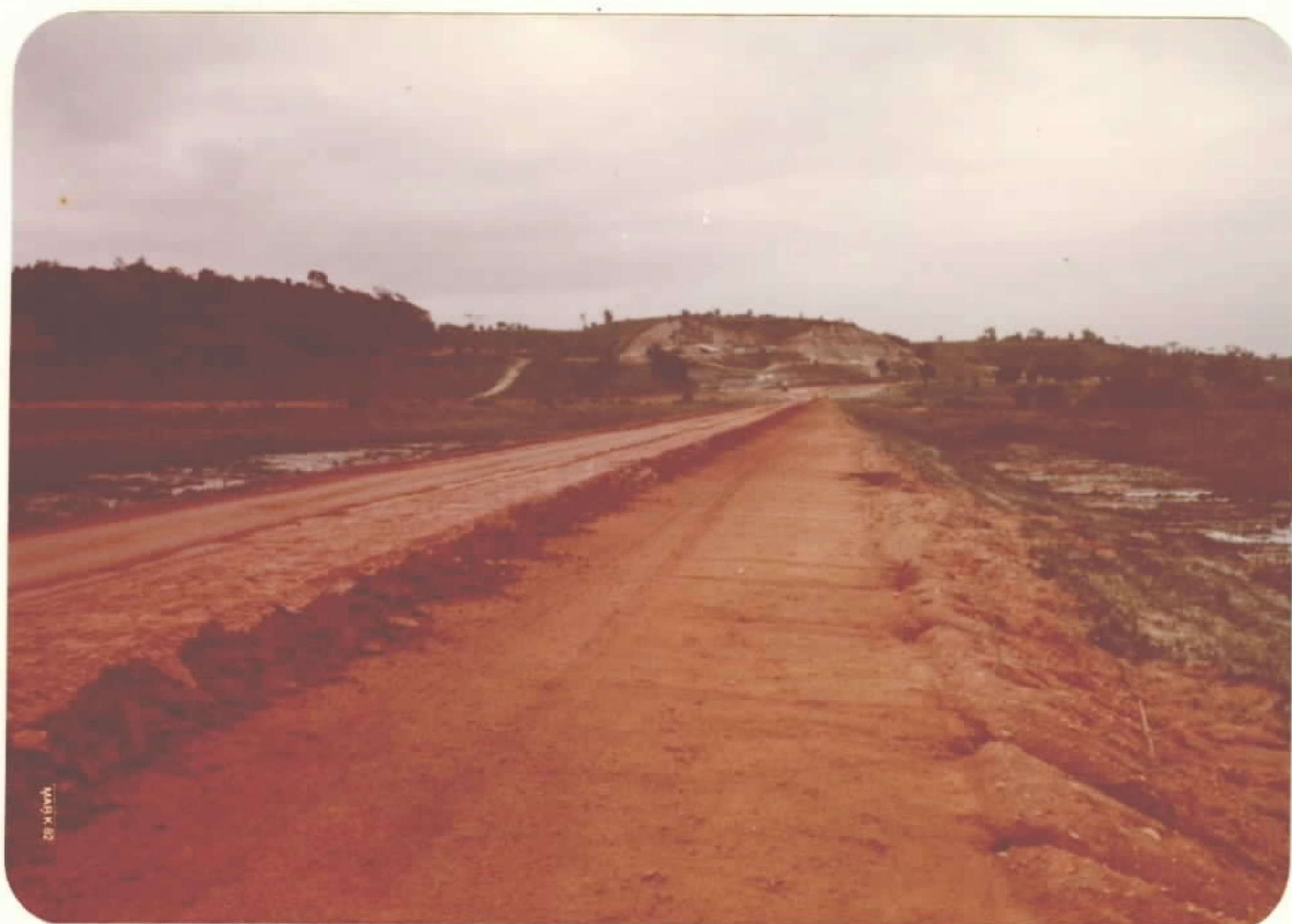
FOTO 10 - Vista da estrada estadual BA-001 próxima a Canavieiras, acompanhando a borda norte da turfeira Marobar. Ao fundo destacam-se falésias mortas da Formação Barreiras. Áreas Canavieiras - Belmonte
