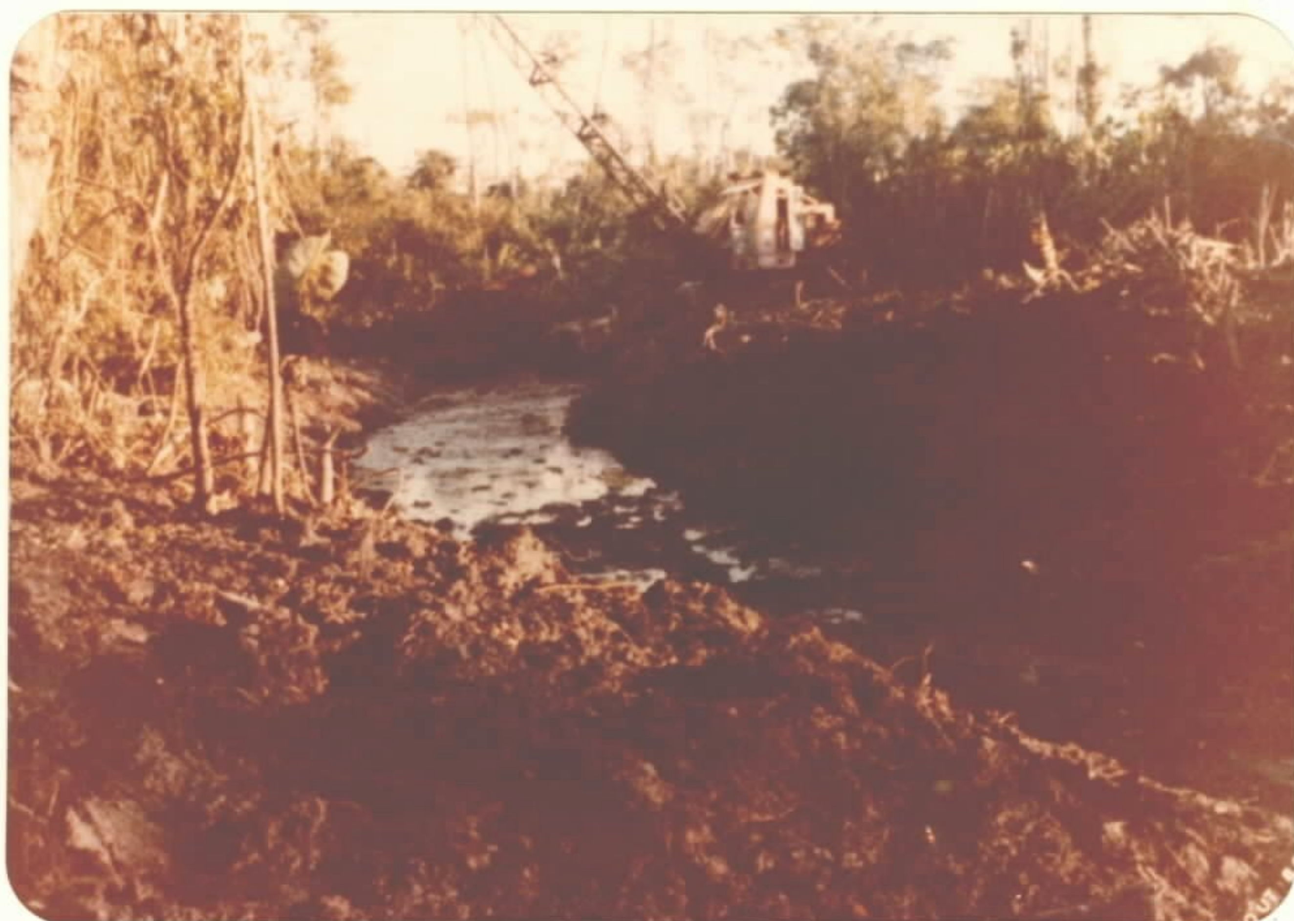
FOTO 11 - Turfa preta, sendo retirada por dragagem em canal de drenagem, próximo ao furo RL-18. Área: Canavieiras - Belmonte
