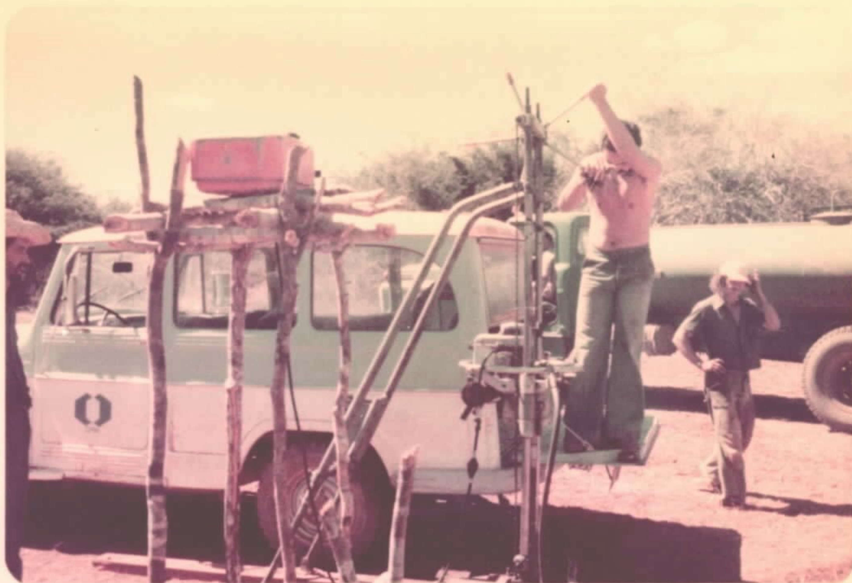
Foto 7 - Perfuração com sonda "Winkie" na parte Sul da área do Projeto.
