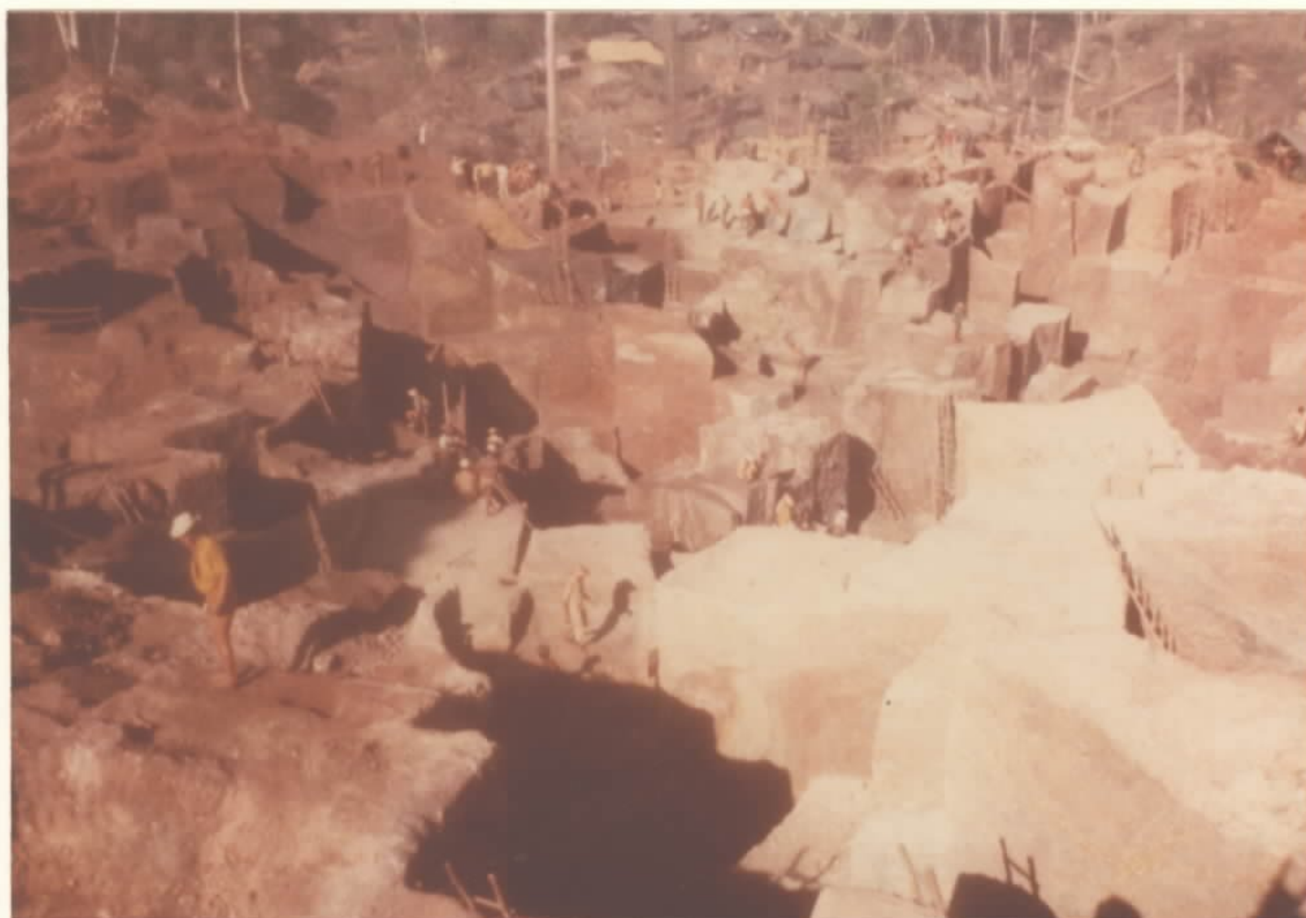
FOTO 03 - Início do desmonte em bancadas na Babilônia I.
