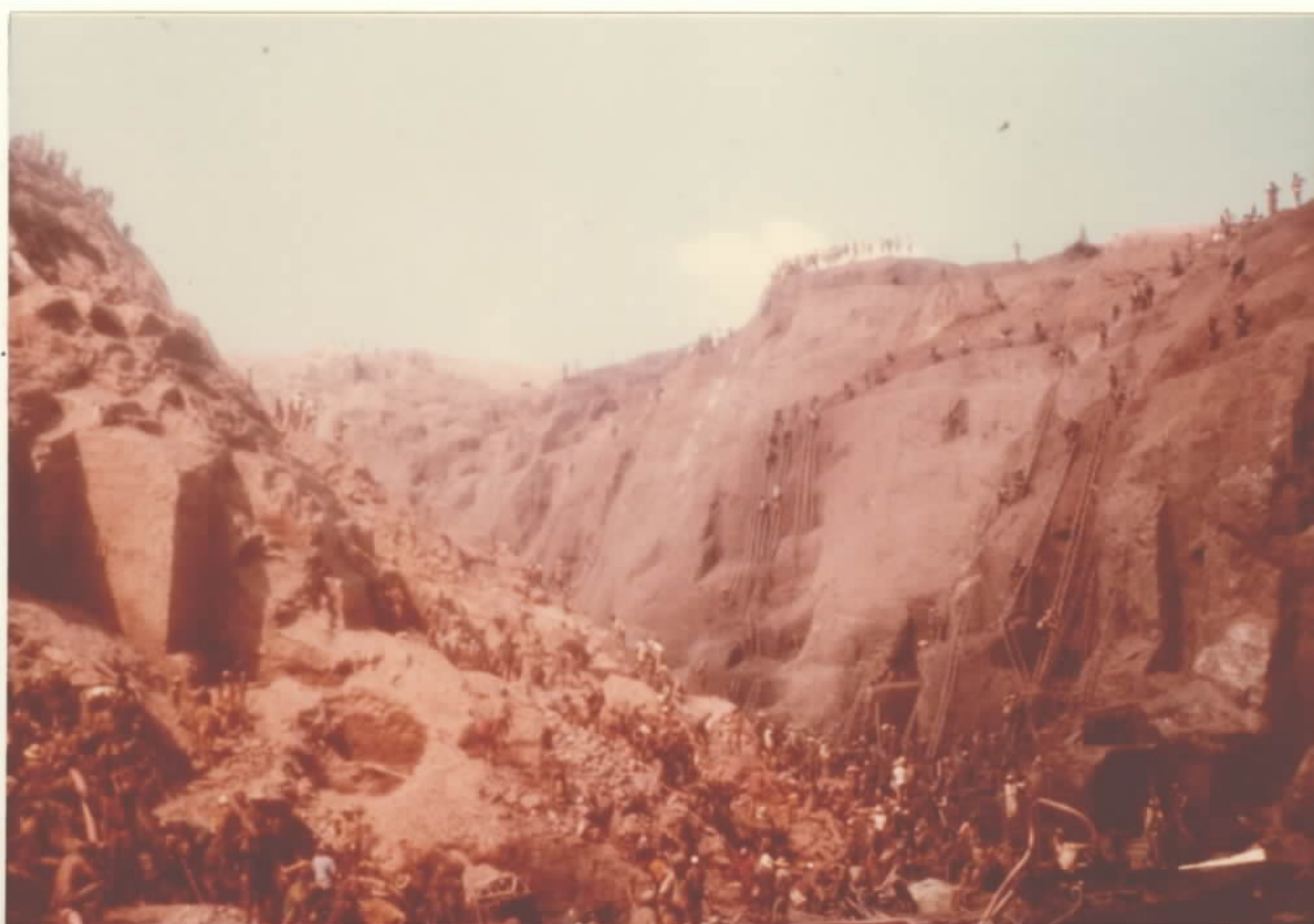
FOTO 13 - Remoção do entulho proveniente do desmoronamento.
