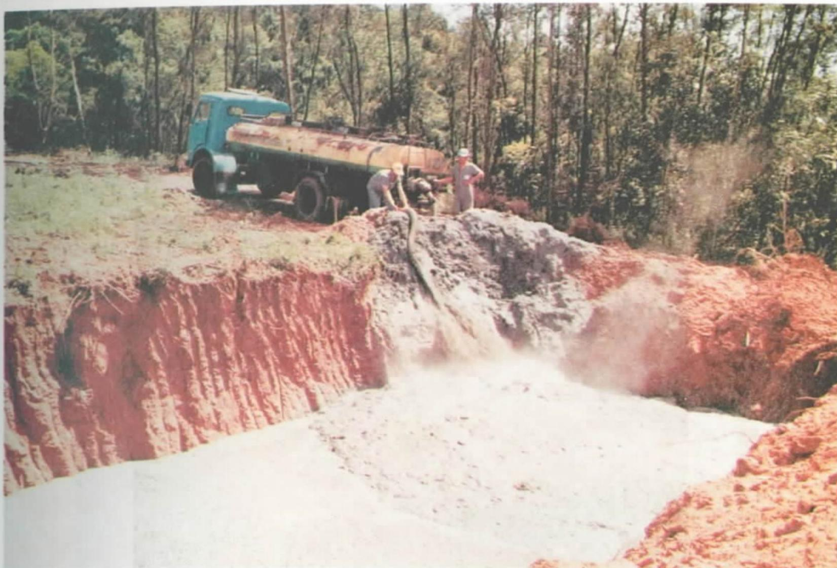
**Foto 17** - Poluição de Aqüíferos - Disposição de lodo industrial diretamente sobre os arenitos permeáveis da Formação Botucatu, no município de Estância Velha, sem a necessária impermeabilização, possibilitando a contaminação do aqüífero.
