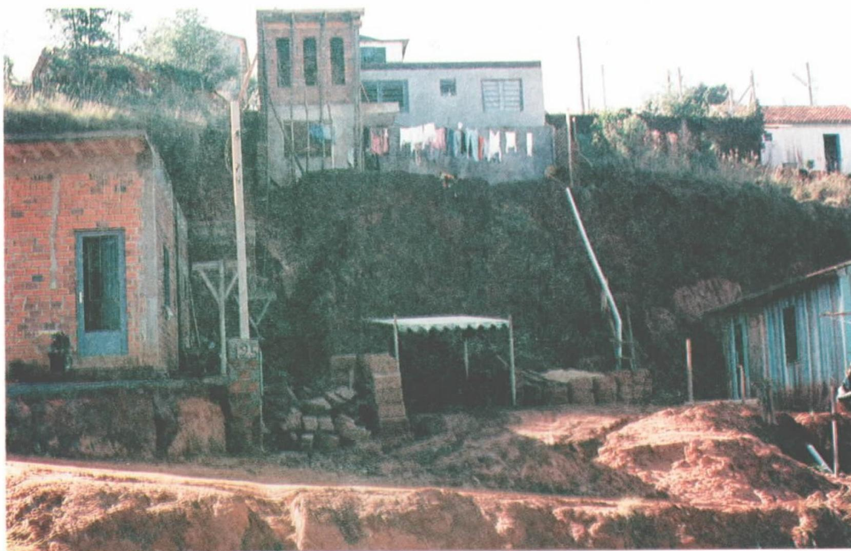
Foto 4 - Ocupação de forma inadequada. Zona Urbanizada em encosta com cortes mal dimensionados, sujeitos a deslizamentos. Loteamento Sol Nascente, município de Estância Velha.
