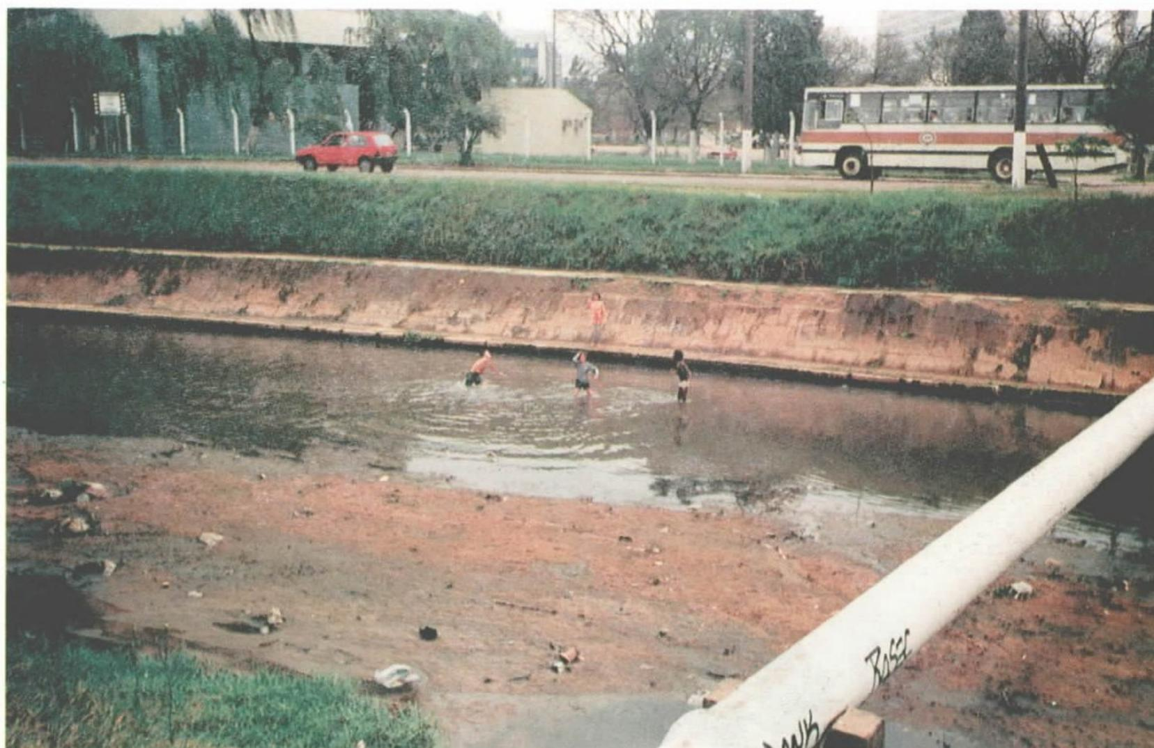
**Foto 12** - Assoreamento - Vista parcial do arroio Dilúvio, no município de Porto Alegre, mostrando o assoreamento de seu leito.
