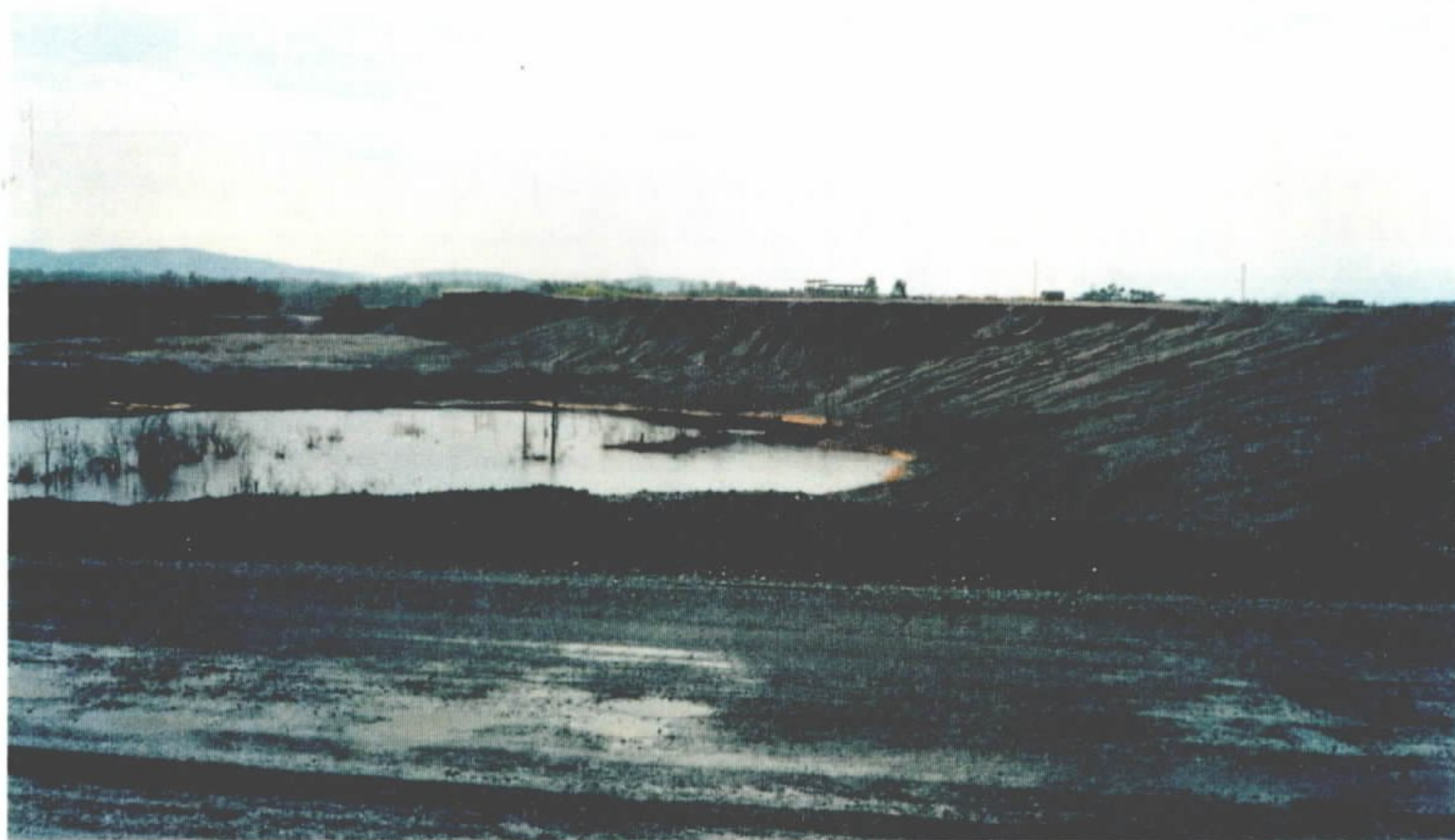
Foto 6 - Pilha de rejeito. Área inadequada para ocupação. Esse material apresenta baixa capacidade de carga para edificações. Quando alterado, origina material argiloso impermeável, que em épocas chuvosas torna-se muito colapsível devido à saturação. Localidade de Sangão.
