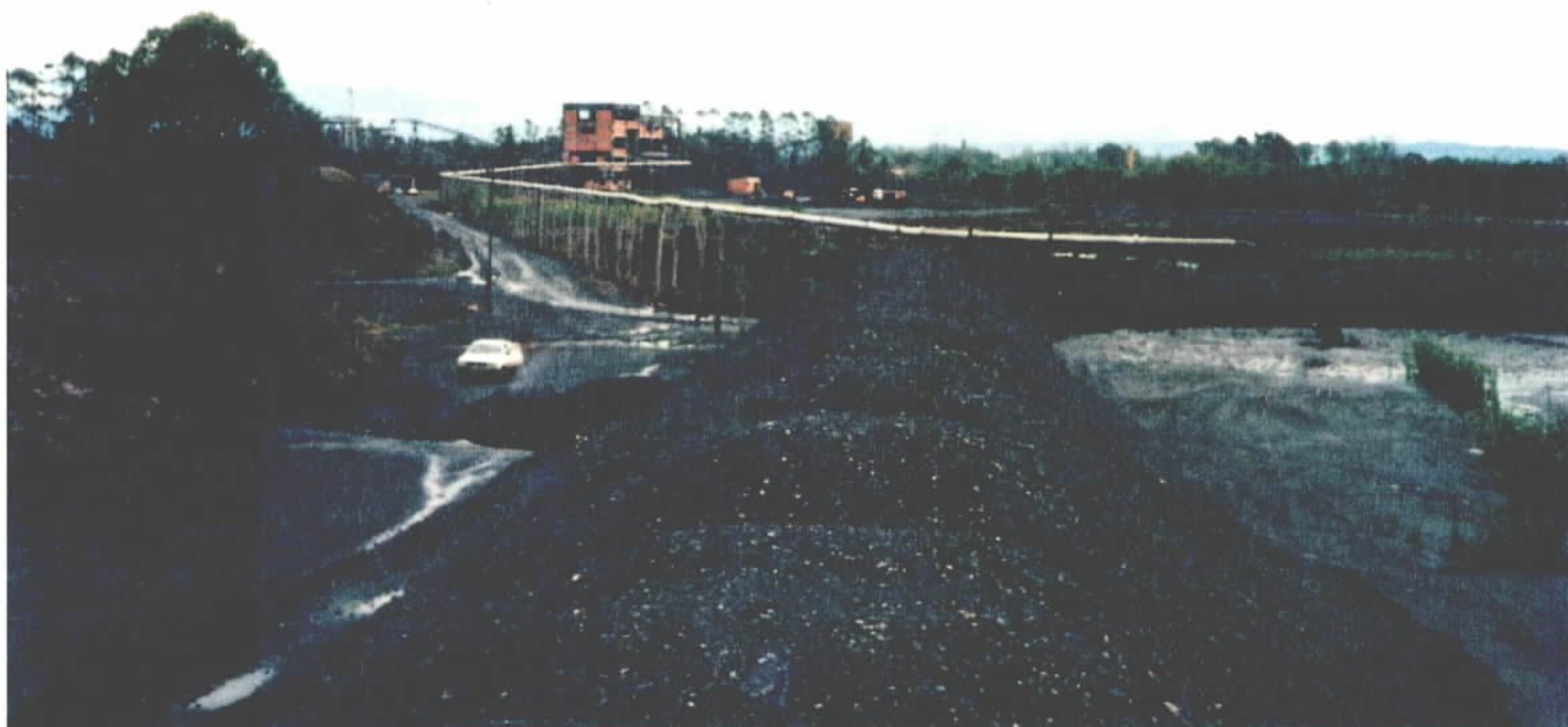
Foto 5 - Bacia de decantação onde são lançados os efluentes provenientes do beneficiamento do carvão. Constitui fonte de poluição dos aquíferos subjacentes. Localidade de Sangão.
