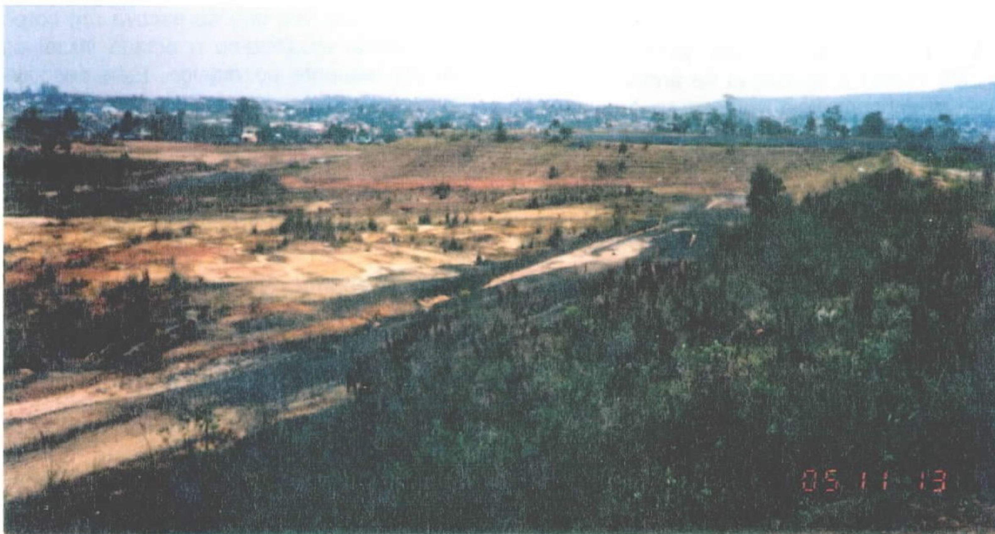
Foto 8 - Recuperação de área degradada. Observa-se ao fundo enorme pilha de rejeito capeada por delgada camada de solo, retirada da área ao lado. Bairro Boa Vista.
