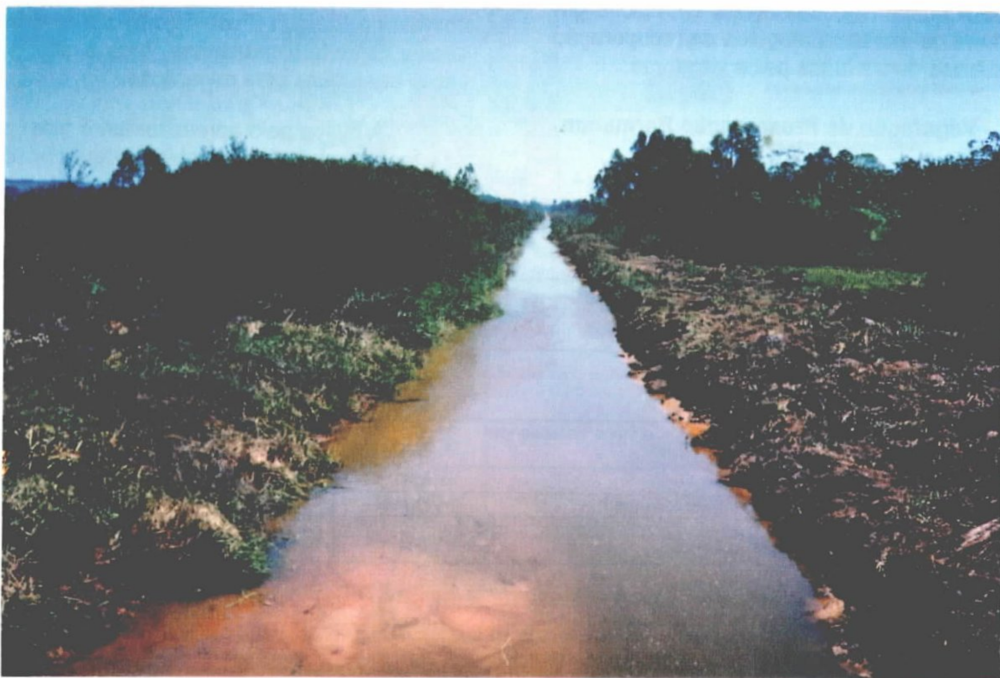
Foto 6 - Rio dos Porcos, canalizado, com margens desmatadas. Um lado recoberto por vegetação secundária (maricás e gramíneas) e outro por material dragado do leito. Novembro. 94.
