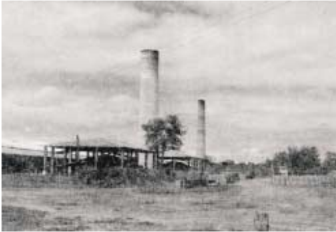
Foto 22 – Instalação industrial de uma cerâmica localizada em Barra dos Gatos, Campo Maior-PI. Afloramento JA-206.
