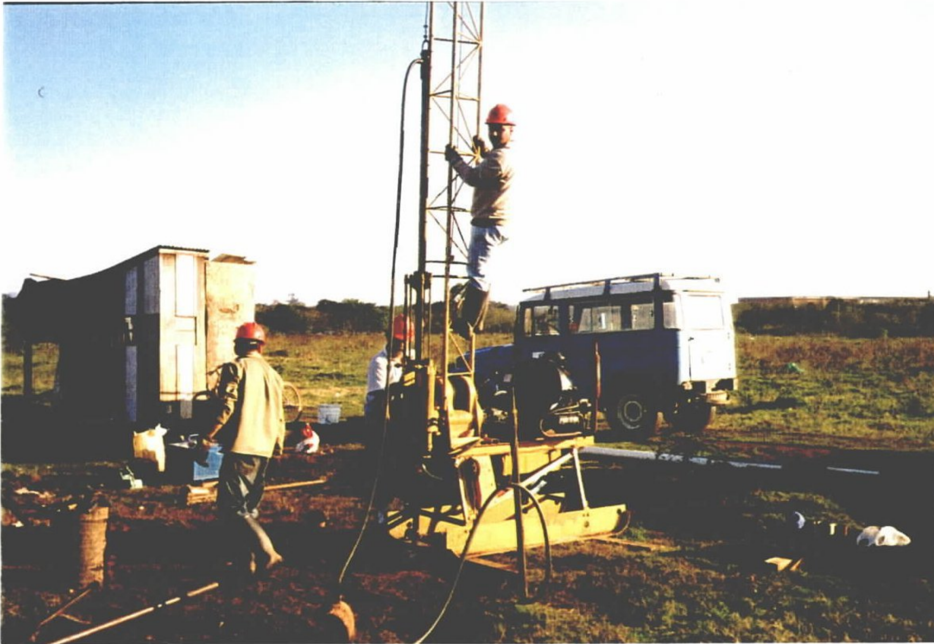
Foto 4 – Detalhe dos trabalhos de sondagem rotativa com a utilização de sonda LongYear, modelo 17, durante a perfuração do furo 15.
