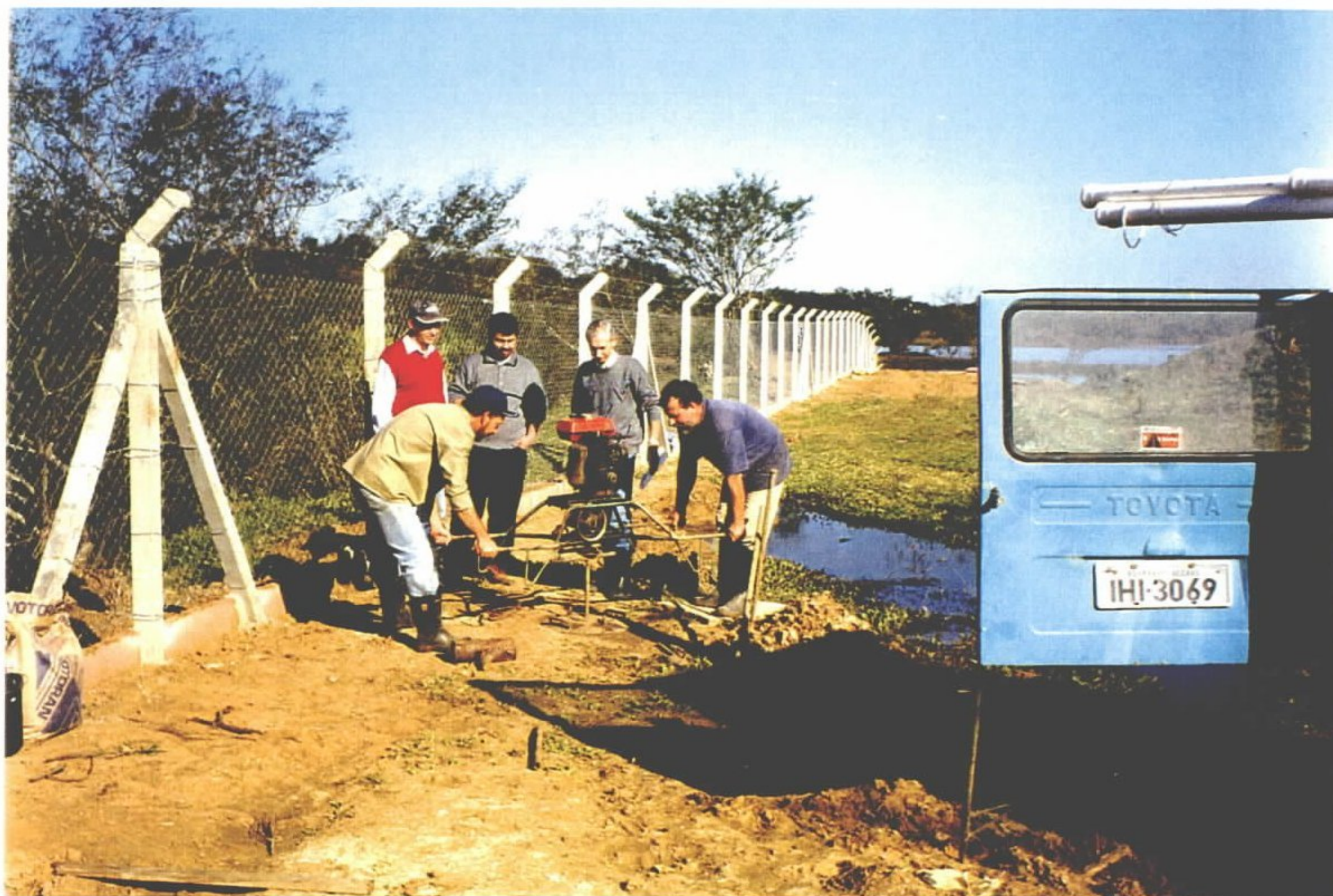
Foto 2 – Operação de sondagem com trado mecanizado. Perfuração do furo 05 utilizando o trado modelo MB-1.
