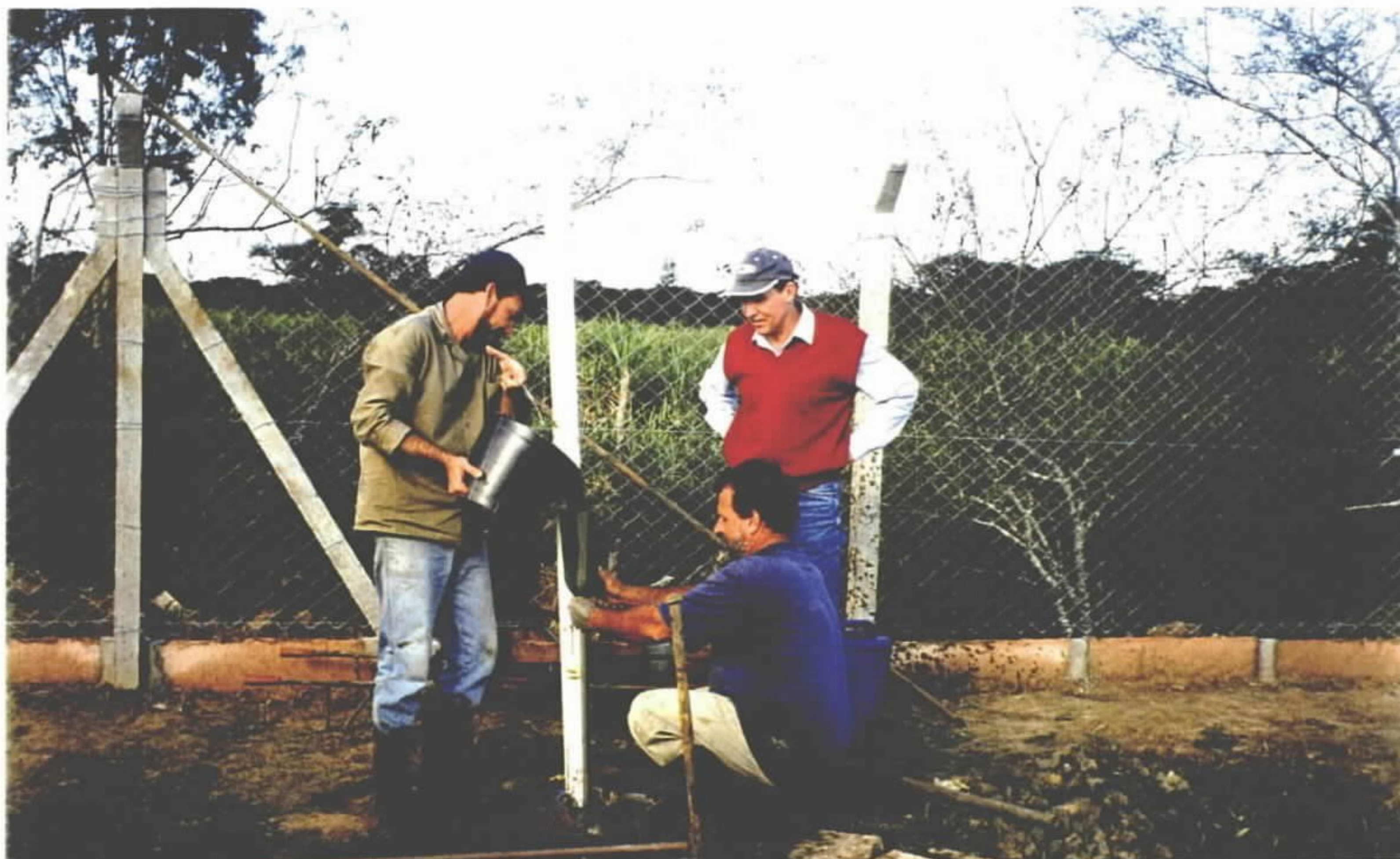
Foto 3 – Isolamento de poço de monitoramento hídrico. Local: Poço 05, situado na margem leste do depósito de resíduos.
